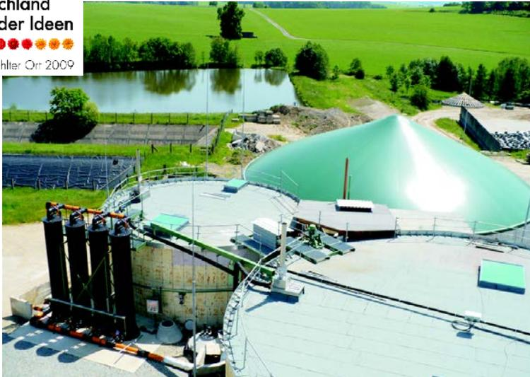
**Unsere Demonstrations- und Modell-Biogasanlage zur Trockenfermentation 499 kW<sub>elektr.</sub>**
